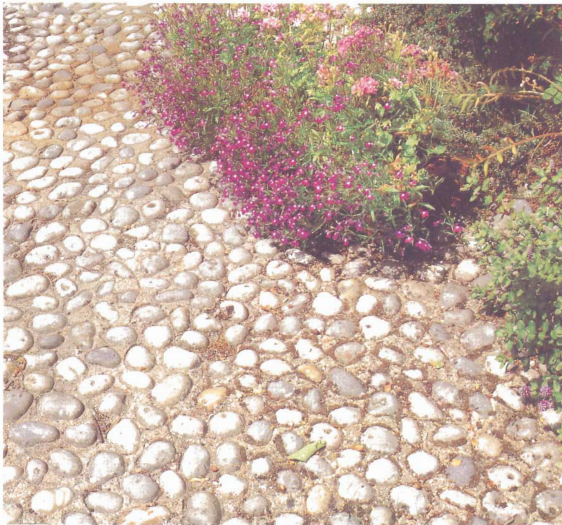
Sỏi được rải đều và ăn liền vào bê tông, rất dễ đi (vườn ông bà W.E.Ninnis)
