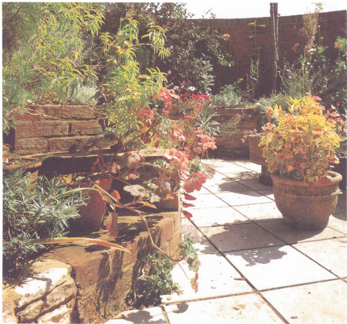
Xây gạch nâng cao góc vườn. Góc vườn cao được đổ đất trồng cây. Còn phần vườn lát gạch thì đặt các chậu hoa.
